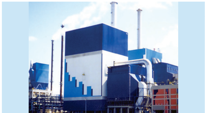
Caldeira de Recuperação Química de 2500tss/d (392t/h), de 91 bar(g) de pressão e 480 °C de temperatura, contratada em novembro de 2000 para a unidade da Suzano em Jacareí-SP. Na época era a maior caldeira do mercado nacional e deu início à escalada de aumento de capacidade nas caldeiras de recuperação para as novas fábricas de celulose no Brasil
