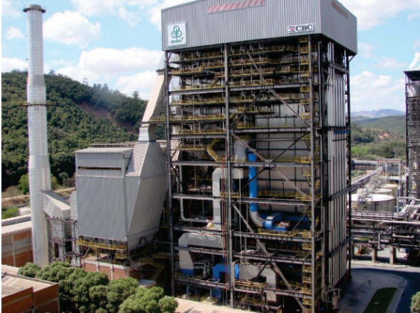
Caldeira de Recuperação Química de 3500tss/d (524t/h), de 66 bar(g) de pressão e 450 °C de temperatura, em operação desde 2006 na unidade da Cenibra em Belo Oriente-MG. Foi a primeira caldeira de recuperação fornecida tecnicamente para futura expansão de capacidade e aumento de pressão, com upgrade para 4200tss/d
