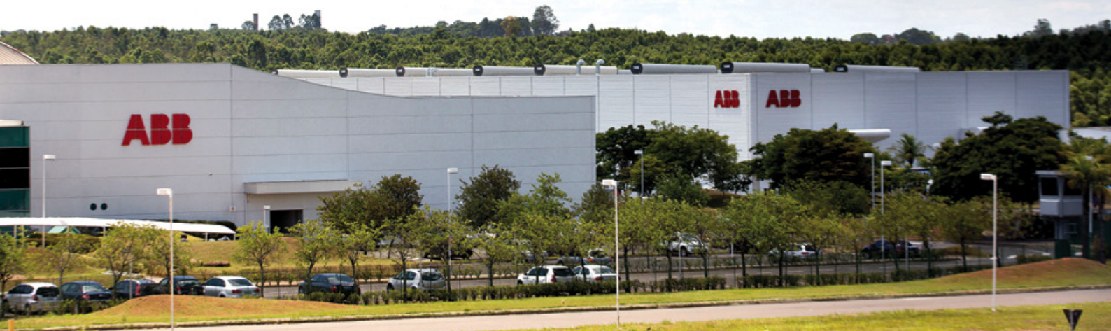
Complexo em Sorocaba (SP) integra a primeira fábrica de eletrocentros do Grupo ABB
